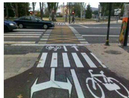
Figura 67 Ejemplo de señalización horizontal.
