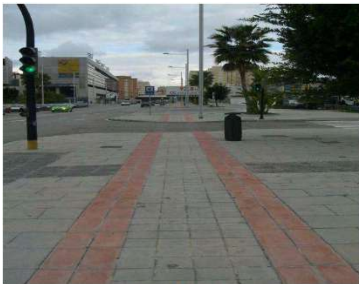
Figura 24 Carril Juan Carlos I sin rebaje ni señalización en la intersección.
