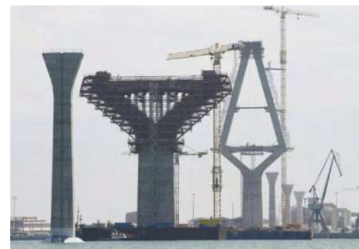
Figura 70 Obras de construcción del Puente de la Pepa.
