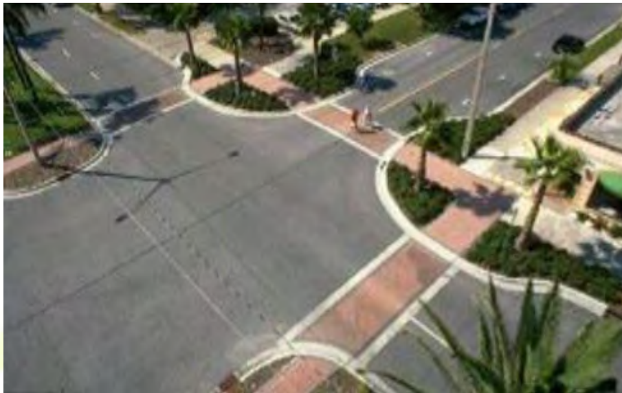
Figura 18 Ejemplo de estrechamiento tipo garganta y marcado de itinerario peatonales.
