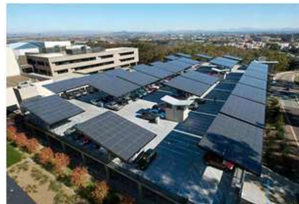
Figura 73 Ejemplo marquesinas solares en aparcamientos 2.
